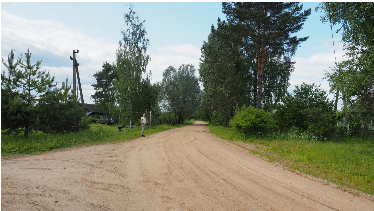
Рис. 23. Калужская область, Спас-Деменский район. 2023 г. Археологическое обследование по объекту: «Уличные газопроводы дер. Жданово». Точка фотофиксации № 7. Вид с востока.
